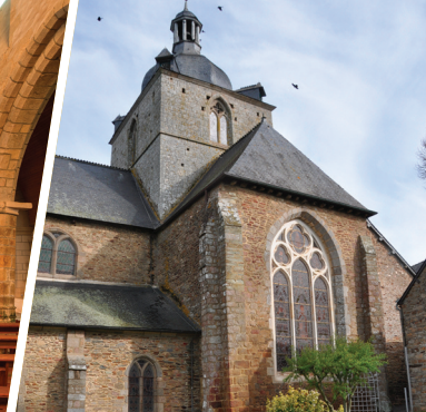
Église de La Trinité-Porhoët.
